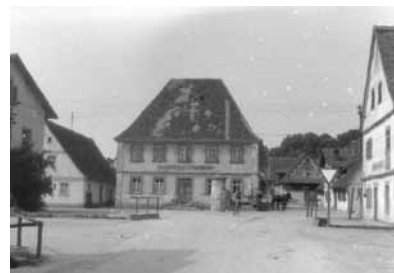
Ehemalige Brauerei Hofmann, heute Rathaus, Hauptstraße 27
