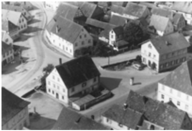
„Altes Schulhaus“, Hauptstraße 26
