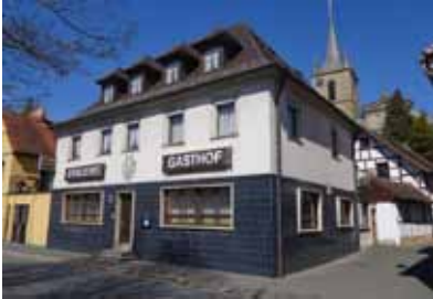
Beispiel für Gaststätte mit Leerstand und großem Sanierungsbedarf bei Haupt- und Nebengebäuden, Hauptstraße 43
