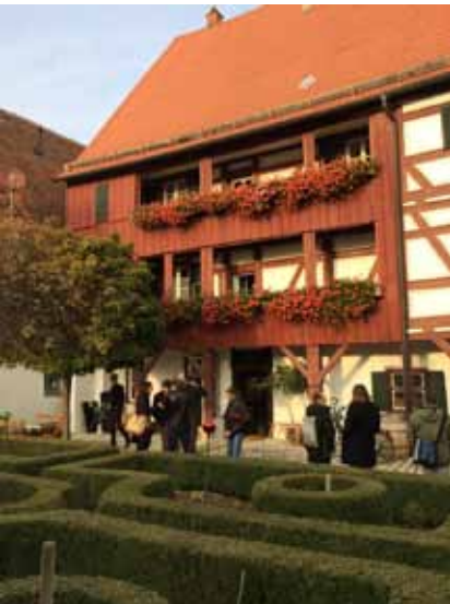
Kurzzeitwohnen für Mitarbeiter im Boarding-House einer Firma in Nördlingen/Ries, Bräugasse
