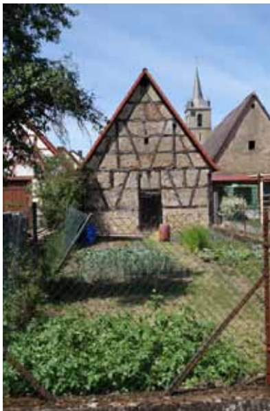
Gebäudestruktur, Beispielgebäude Hartmannstraße 13, Schuppen, Hofraum, Scheune mit Garten
