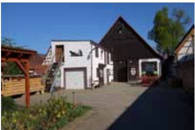
Gebäudegerechte Weiternutzung eines Stadels als Pferdestall, Hauptstraße 25
