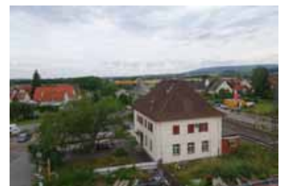
Blick vom Lindner-Gebäude nach Süden mit Freifläche im Bahnhofsgebäuden und Gleiskörper
