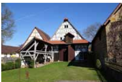
Scheune und Nebengebäude Hauptstraße 34 vor und nach der Sanierung (Oberes Bild: Eigentümerin Hauptstr. 34)
