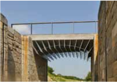
Schleuse 94, heutiger teilweise rekonstruierter Zustand Quelle: Markt Eggolsheim
